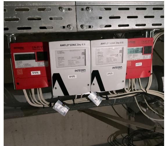
▲ Abb. 1: Energieversorgungstunnel mit Nahwärme und Nahkälte sowie Wärme- und Kältezähler im Energieversorgungstunnel
